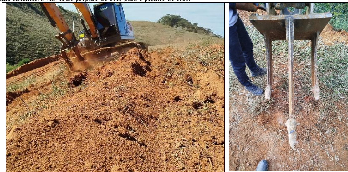
Abertura dos sulcos, com escavadeira hidráulica e vista frontal do garfo utilizado
