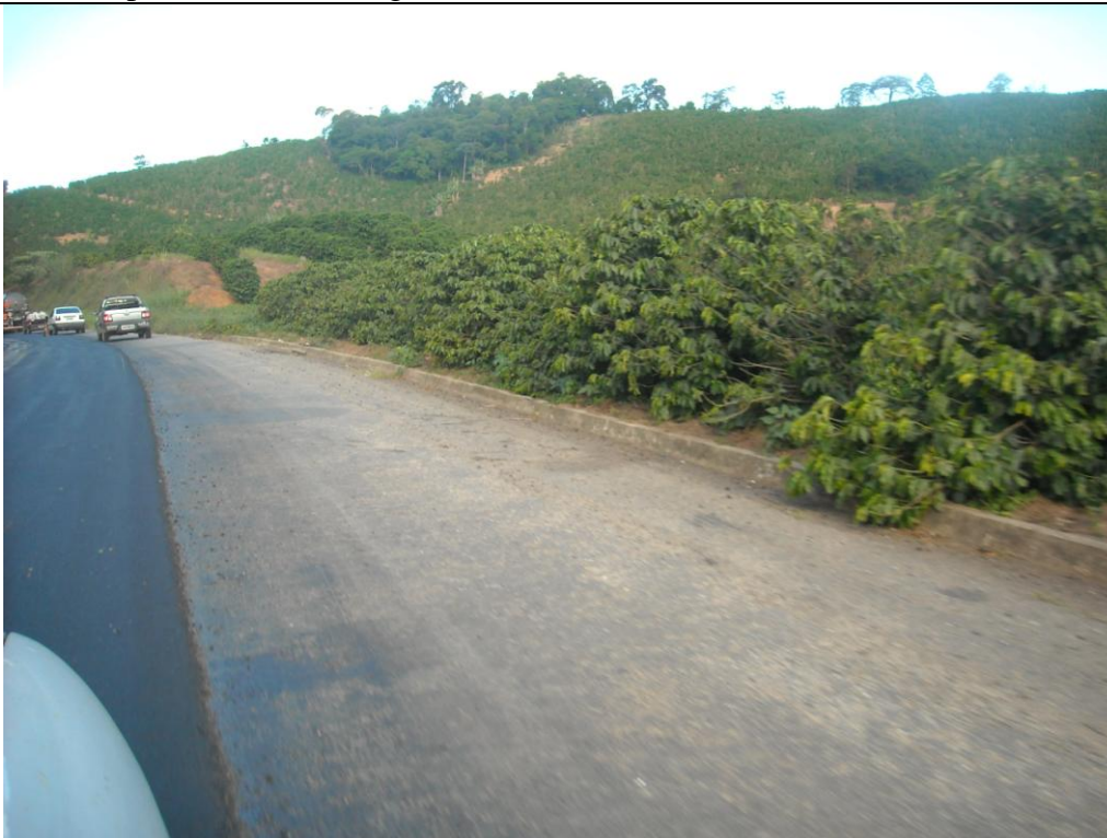
Figura 1: Nas margens da BR 262, que liga Minas ao Espírito Santo, entre a Zona da Mata e o Sul do ES, cafezais ocupam a faixa de domínio, vendo-se cafeeiros junto ao meio-fio do acostamento.
